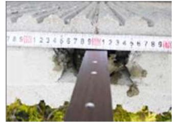
支柱の水抜き穴に5寸釘等を差しブロックに設置します。水抜き穴を利用する事で支柱の高さを簡単に揃える事ができます。
